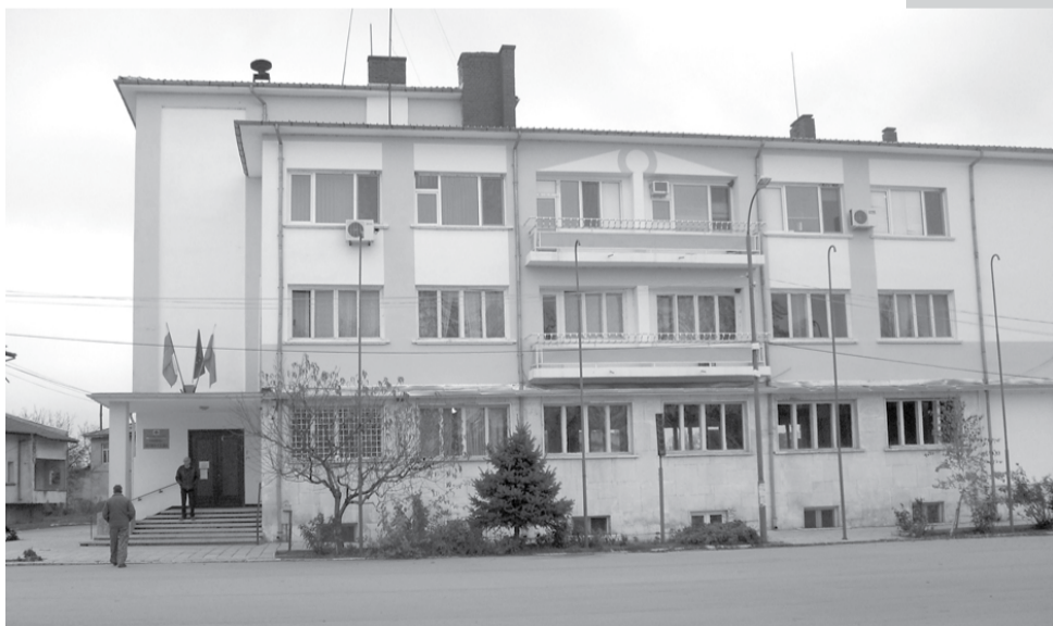
Сградата на Общината в Ново село.
